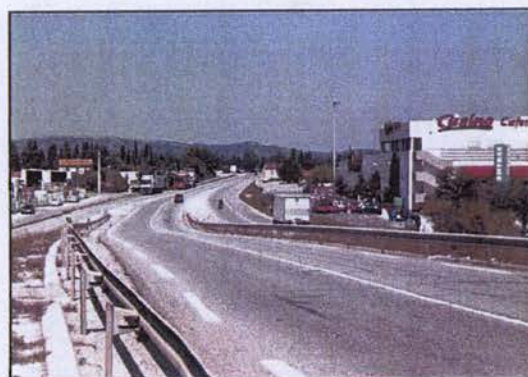
LA BARRIERE DES INFRASTRUCTURES GENERE DES NON-LIEUX
